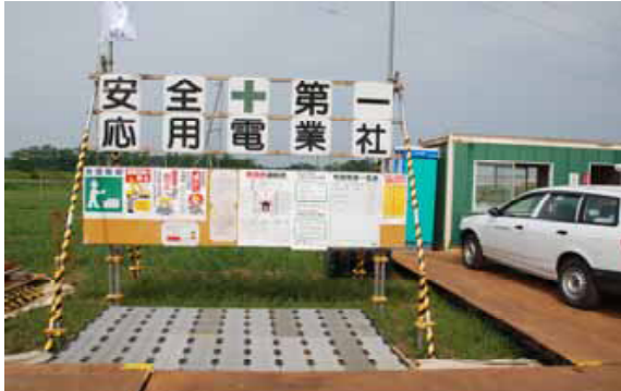
現場安全看板付近【歩行箇所設置】
