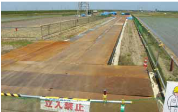
鉄塔、架線工事【仮設路、塔内仮設設置】
