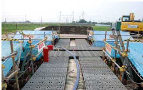
鉄塔基礎工事【塔内通路設置】
