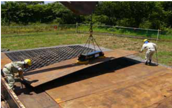
架線工事【ドラム場仮設設置】
