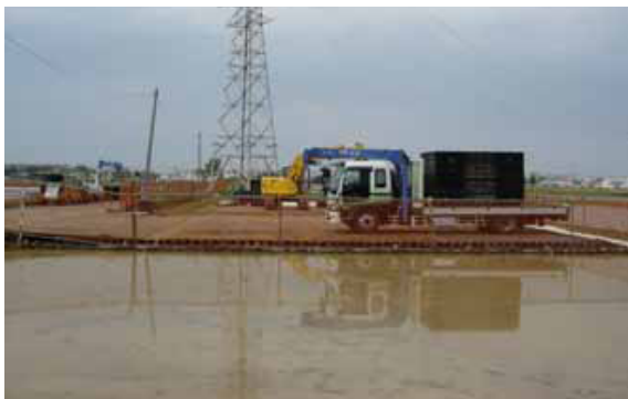
架線工事【ドラム場 湛水箇所設置】
