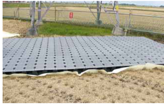
架線工事【作業箇所、資材仮置箇所設置】
